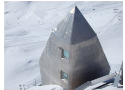
GFZ-Messstation auf der Zugspitze
